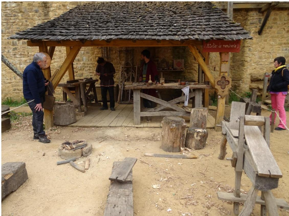
Les charpentiers réalisent tous les ouvrages en bois du château : **charpentes, portes, herses, coffrages...** ainsi que les **échafaudages** et les **engins de levage** nécessaires à la construction.
