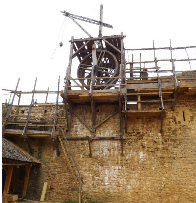
La **cage à écureuil** est le plus spectaculaire et permet de monter les plus lourdes charges. Elle peut être à simple ou à double tambour. Grâce à la force humaine, une cage à écureuil peut soulever jusqu'à **500 kg**.
