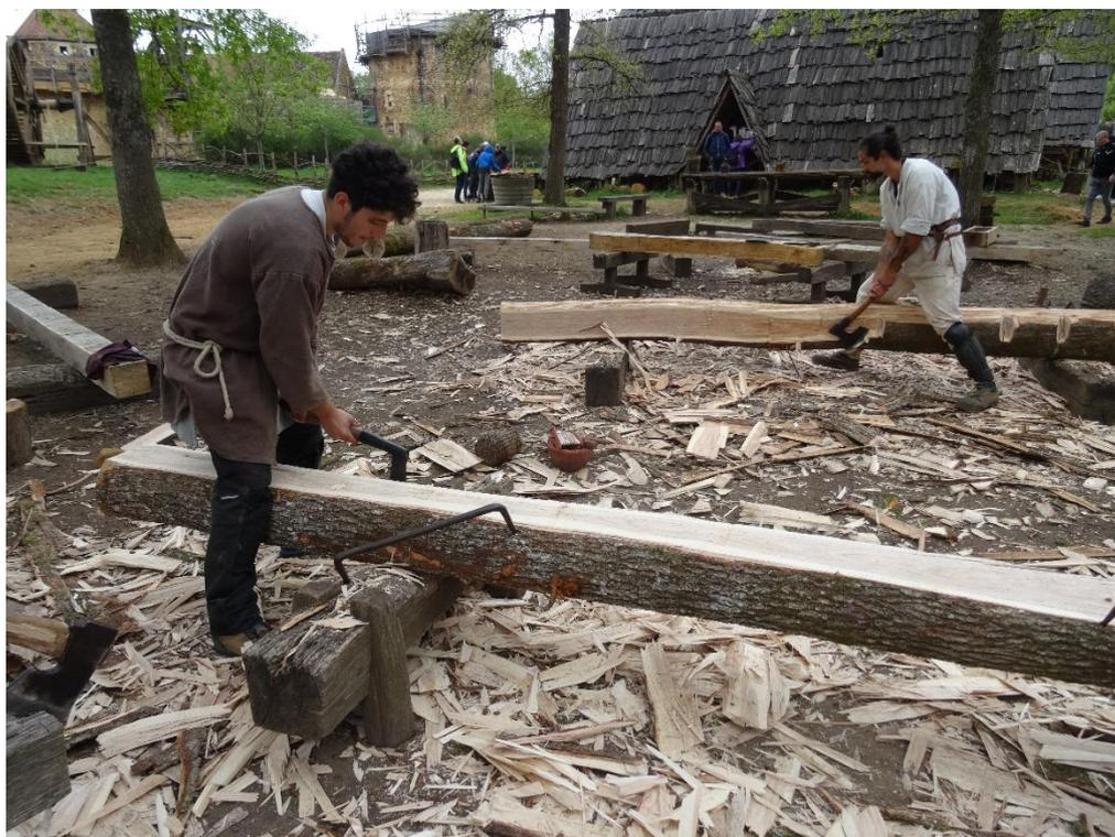
S'il est besoin, ils posent cette poutre sur une "chèvre" pour la couper en planches avec une scie de long (Scie de long ou scie à 4 mains ou niargue composée d'un cadre d'une lame tendu par un écrou et d'une poignée, servant à déligner les troncs pour en faire des planches). Le scieur du haut se nomme le "chevrier", celui du bas est le "renardier".
