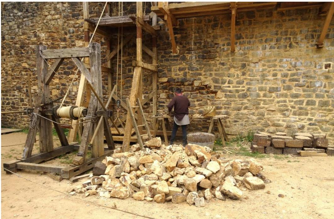
Les maçons **construisent les murs** et réalisent la forme globale d'un édifice et **maîtrisent l'assemblage d'ouvrages sophistiqués** comme les voûtes, les fenêtres gothiques, les coupes... Au-delà de la **géométrie**, les maçons maîtrisent aussi les **calculs de charge**. Une voûte d'ogives, comme celle du premier étage de la tour maîtresse, représente **100 tonnes** de pierre et de mortier au-dessus du vide.
